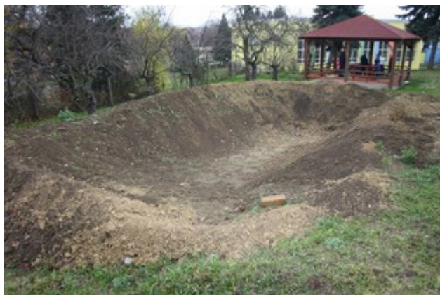
Proběhly výkopové práce.
